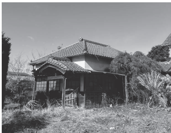
写真2：解体前の旧「石橋医院」診察室外観
